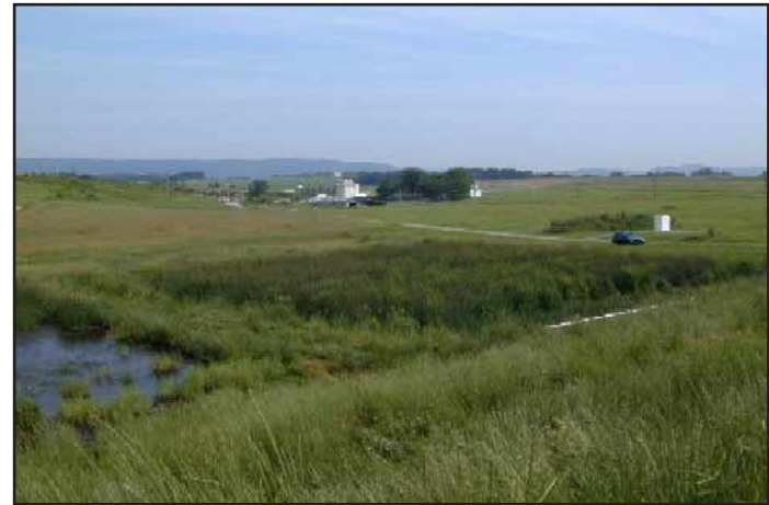
Εικόνα 2β. Τελική μορφή του τεχνητού υγροτόπου στην Pennsylvania (ΗΠΑ) μετά το πέρας των εργασιών.
