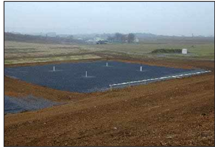
Εικόνα 2α. Εργασίες κατασκευής τεχνητού υγροτόπου επεξεργασίας αστικών λυμάτων στην Pennsylvania (ΗΠΑ)
